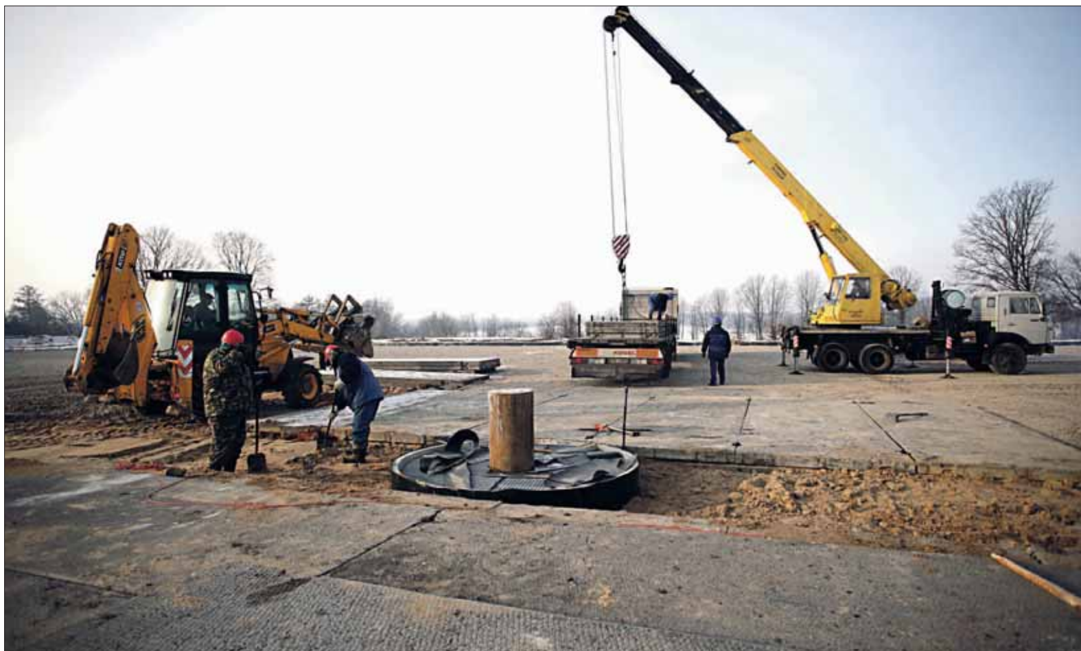
Labores de excavación de uno de los pozos que BNK tiene en Polonia y que se asemeja a los que se quieren construir en Burgos. / BNK
