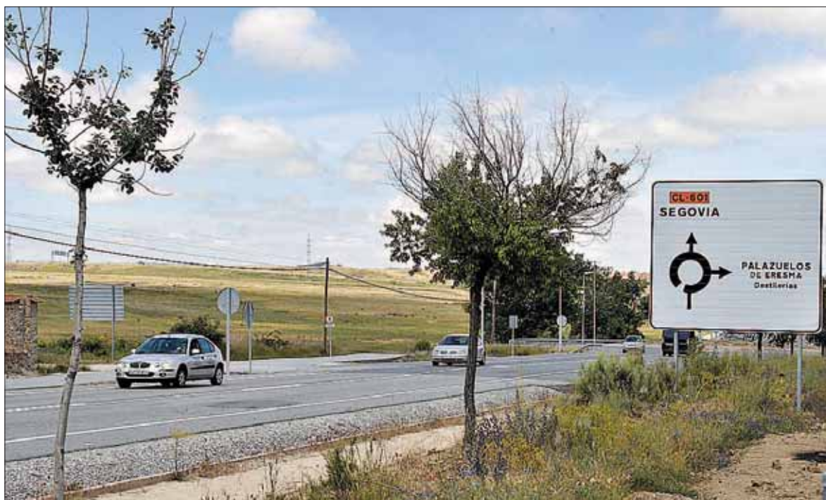
El presidente de la asociación lamenta el mal estado en el que se encuentra la carretera de Segovia a La Granja. / KAMARERO
