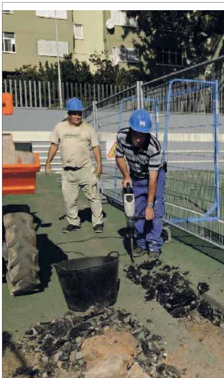
Unos operarios de obra levantan el asfalto para hacer una cata. / EUROPA PRESS
