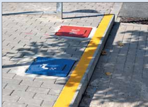
Arquetas para vaciado de aguas. / BORJA MARTÍN
