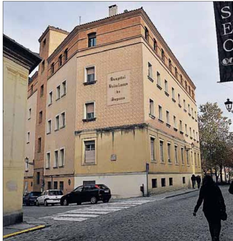
Fachada del edificio del antiguo Policlínico, en la calle San Agustín. / KAMARERO
