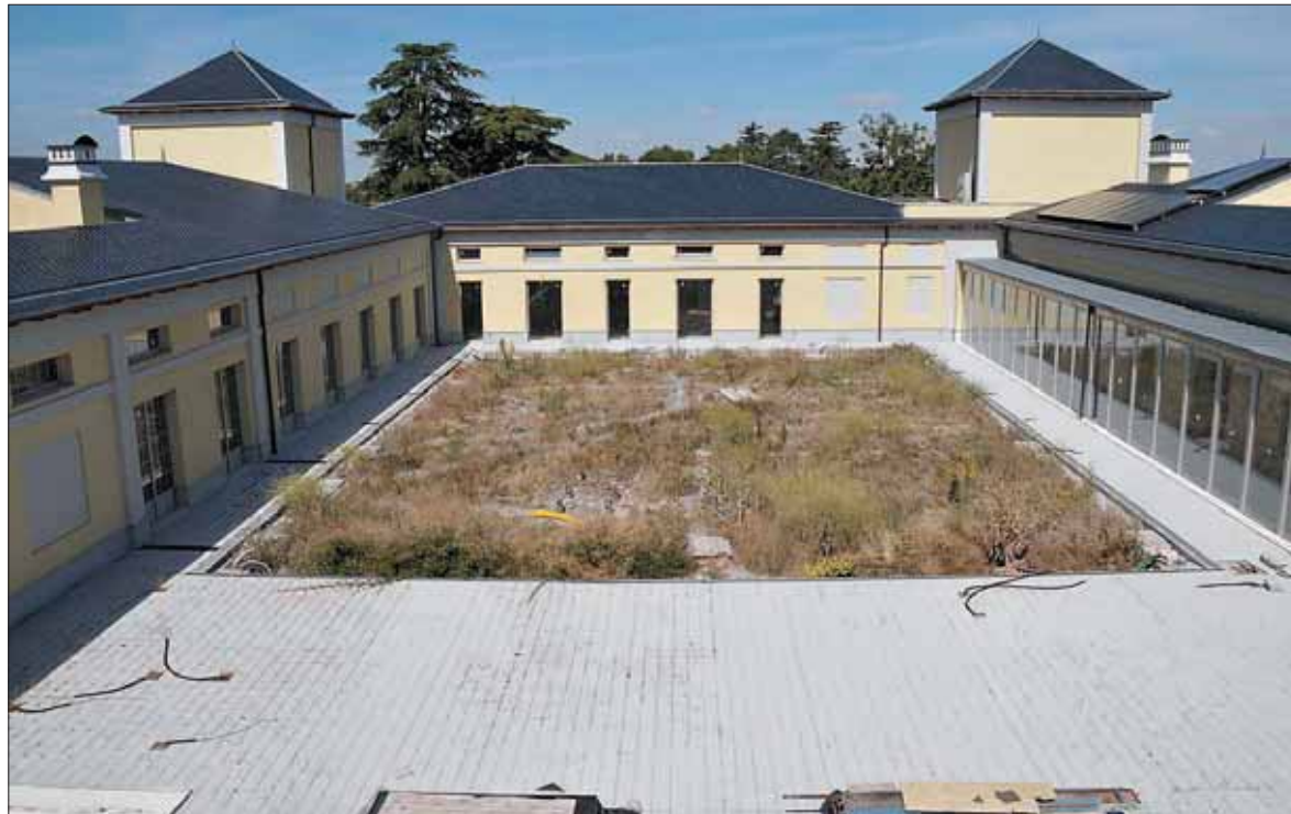
Exterior de La Faisanera, que se está acondicionando como palacio de congresos. / JUAN MARTÍN
