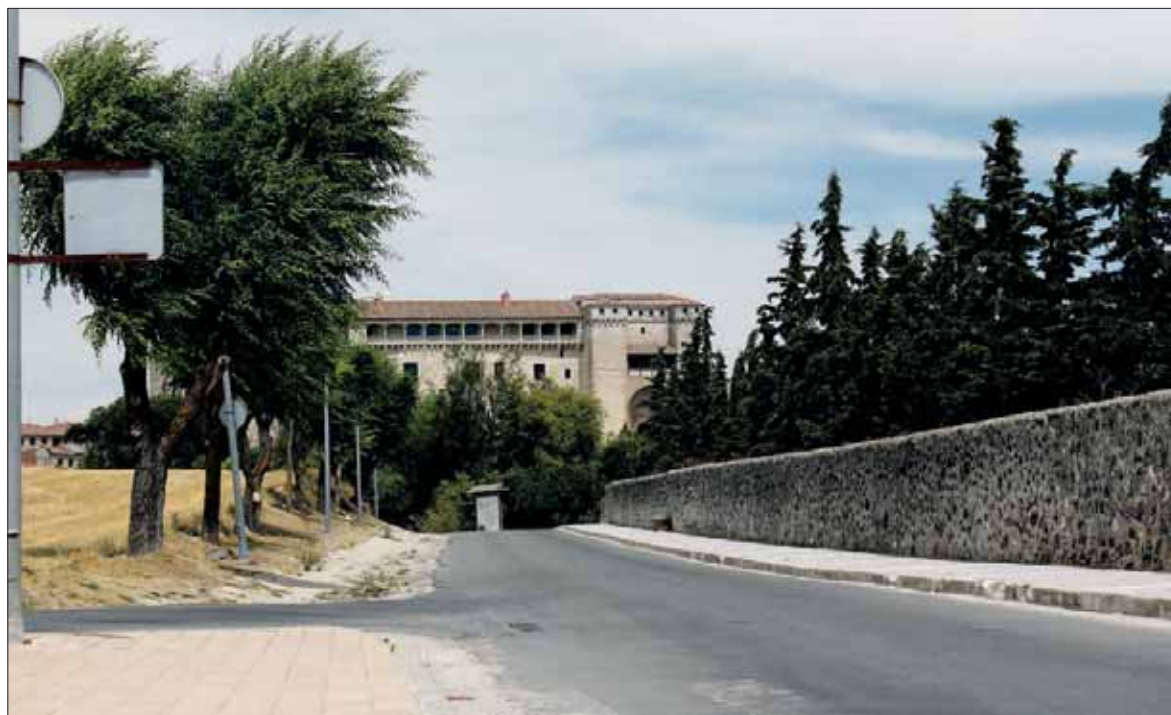
Camino de 'El Alamillo' en el que se instalarán redes de saneamiento y una acera de dos metros de ancho. / CHANTAL NÚÑEZ
