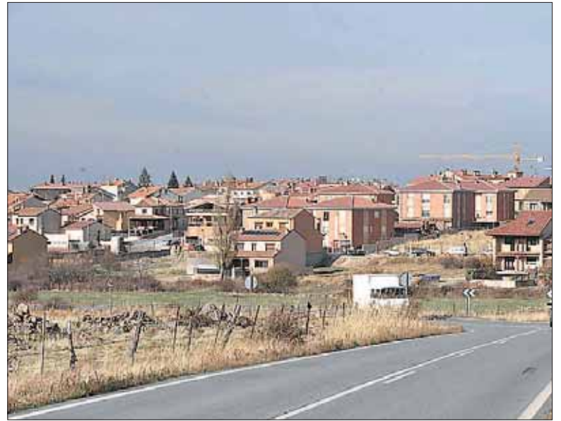
El colector es una obra muy necesaria y esperada en San Cristóbal. / KAMARERO
