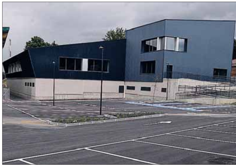
El edificio del complejo deportivo está casi construido. / JUAN MARTÍN
