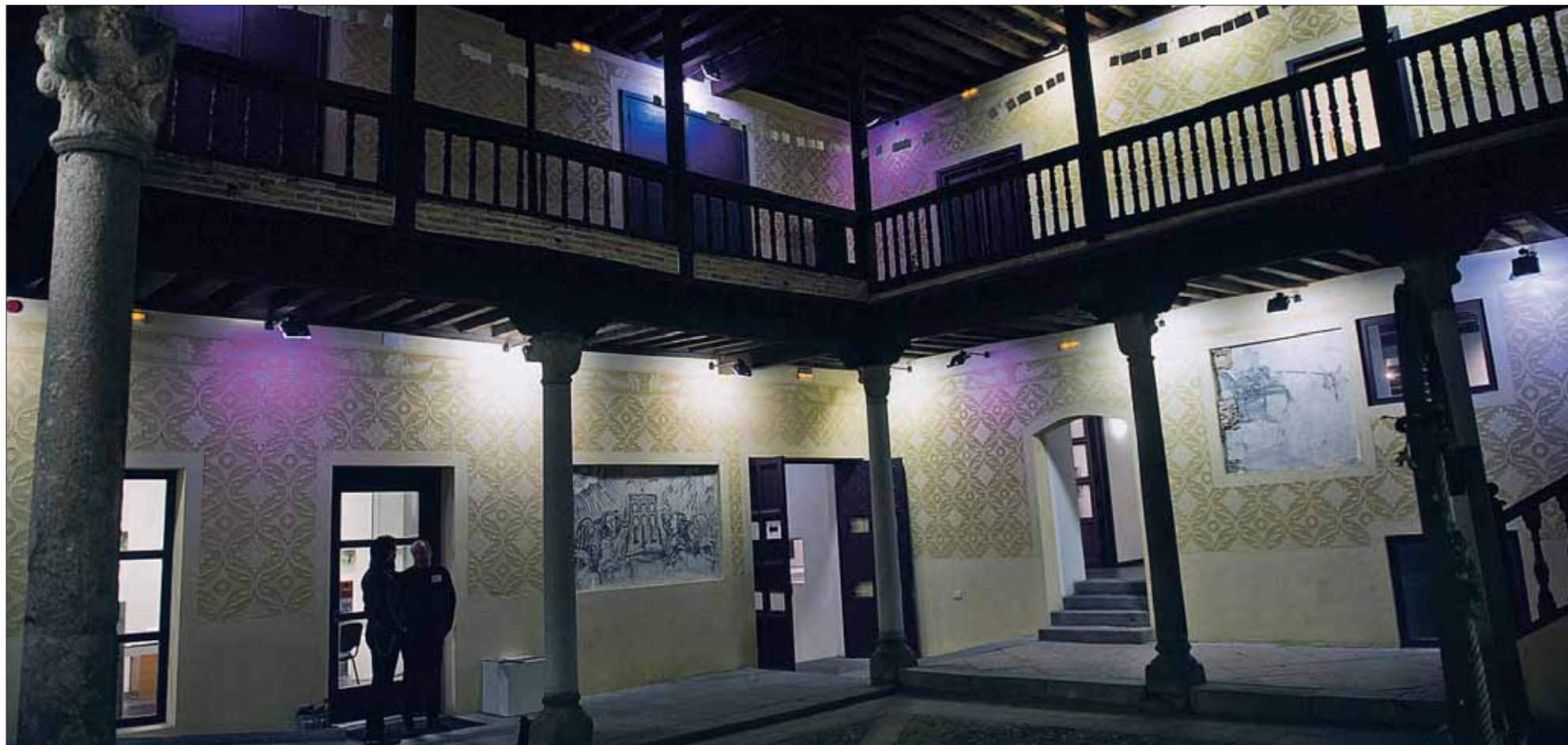
Las obras de rehabilitación integral del Palacio de Quintanar ejecutadas por la Junta de Castilla y León entre 2007 y 2011 adaptaron el edificio para desarrollar múltiples actividades al mismo tiempo. / KAMARERO
