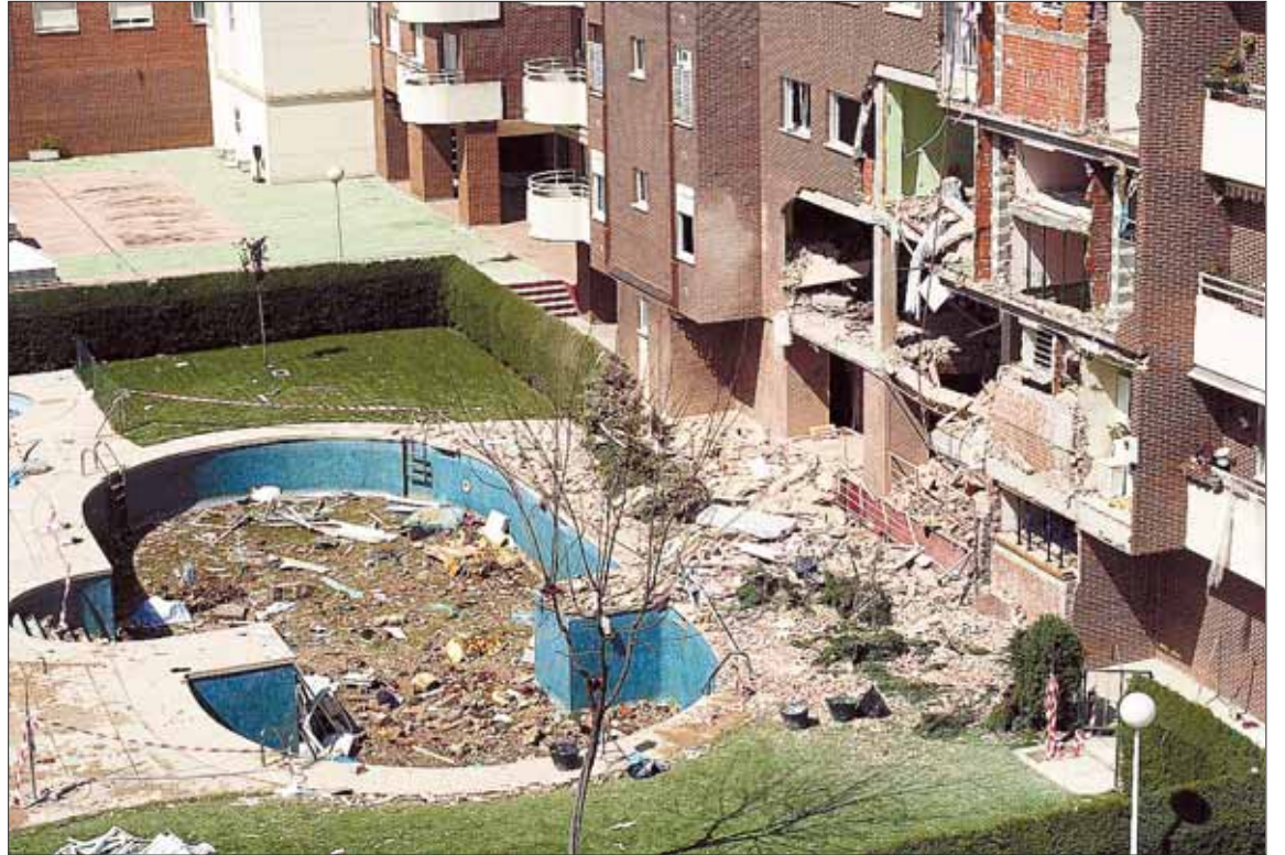
Así quedó el bloque de viviendas tras la explosión provocada por los 'yihadistas' que mató a un agente. / EFE
