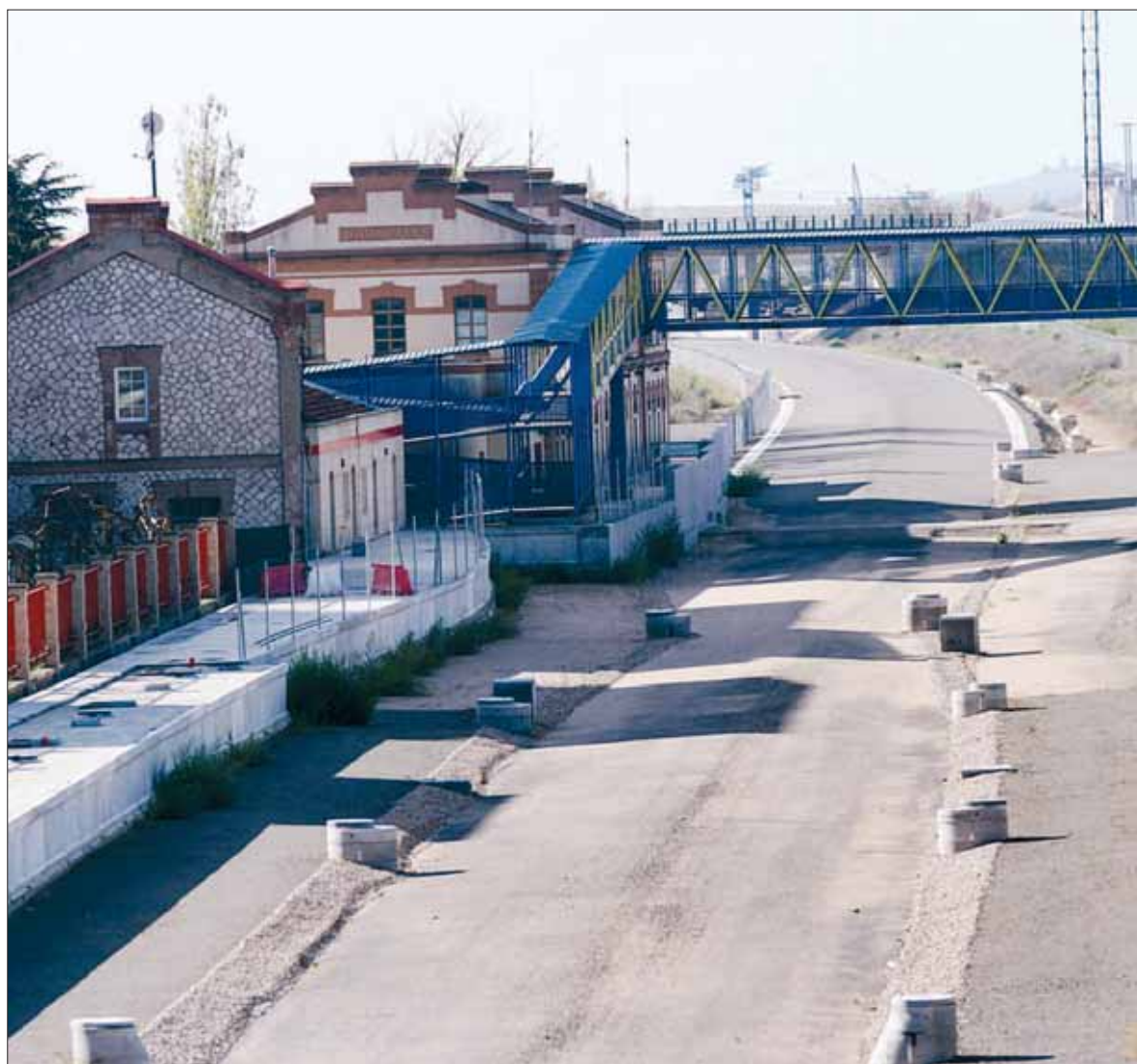
Imagen de archivo de las obras del AVE en la estación de trenes de Venta de Baños (Palencia). / BRÁGIMO (ICAL)
