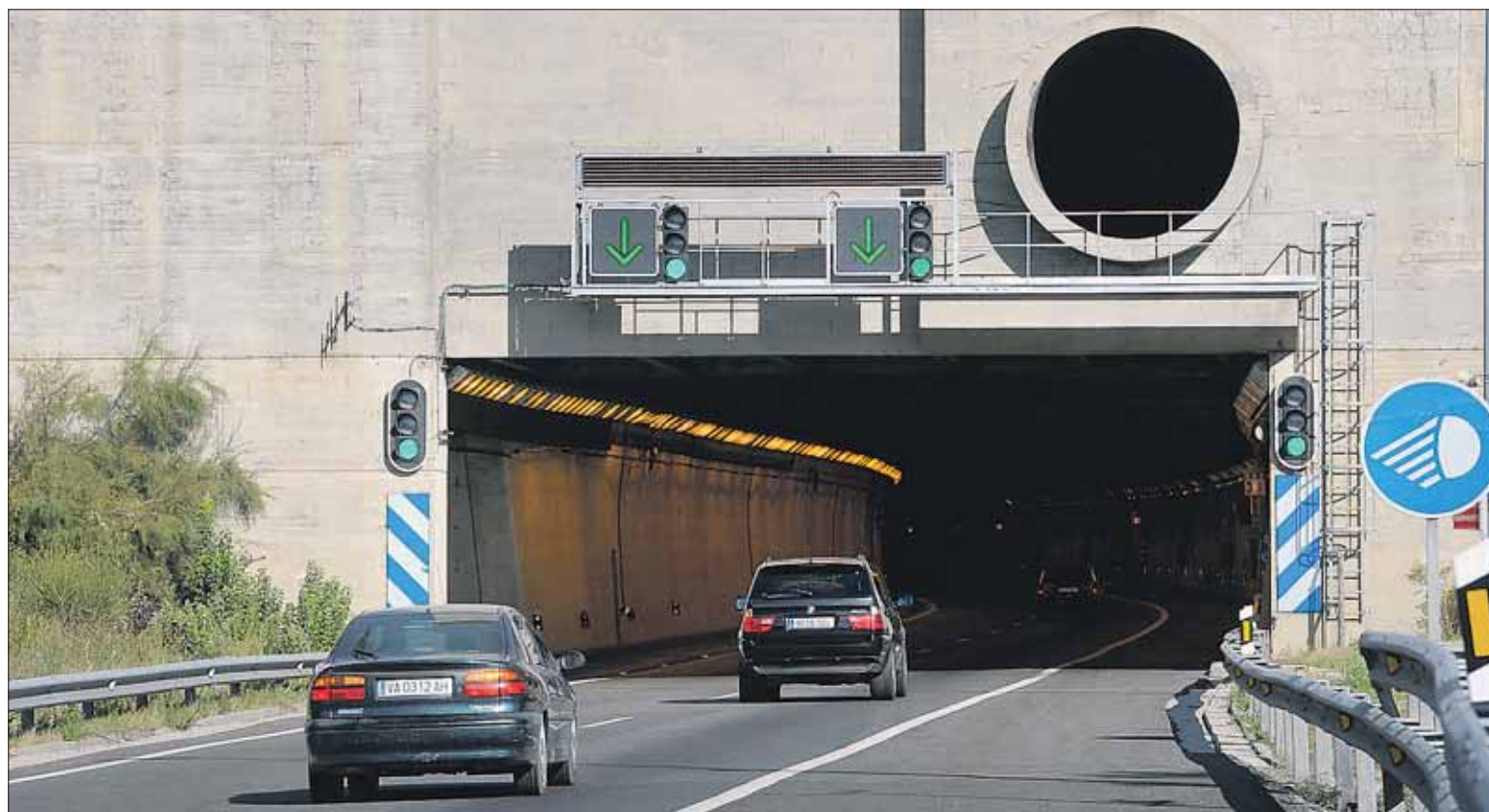
Imagen de la entrada a uno de los túneles de Guadarrama que pertenecen a la autopista AP-6, la de mayor intensidad circulatoria de toda España. / KAMARERO
