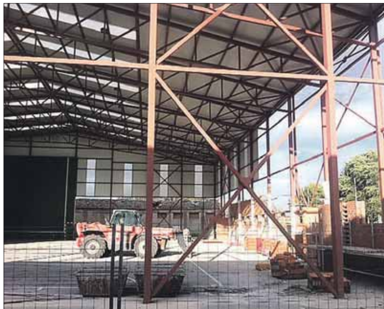
Obras de cerramiento en el pabellón polideportivo de Navalmanzano. / EL ADELANTADO
