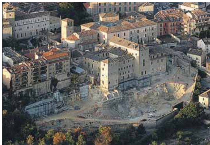
Imagen aérea de las obras de excavación del solar. / JUAN MARTÍN
