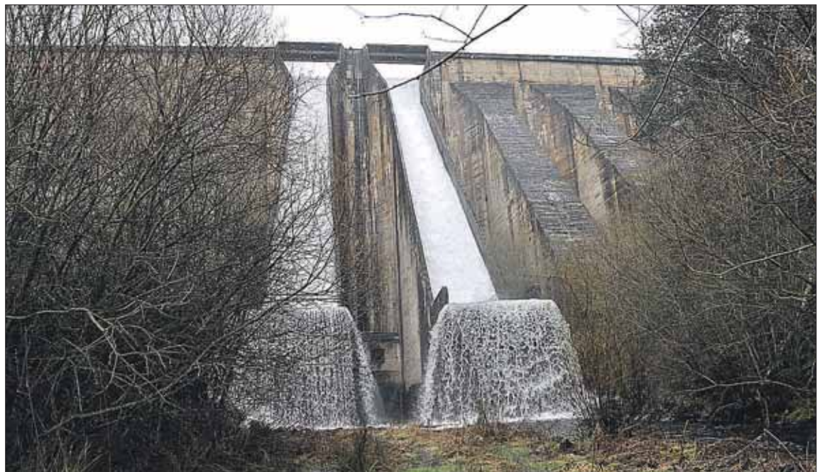
La presa de Puente Alta, en Revenga, fue construida en la década de los 50 y es propiedad del Ayuntamiento de Segovia. //J.M.
