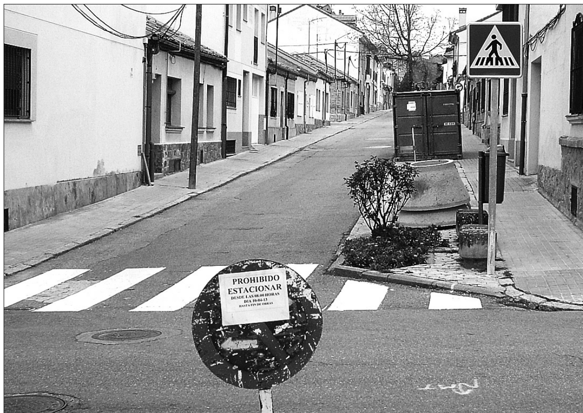
Imagen de la calle Santa Bárbara ayer lunes, cuando estaba previsto el comienzo de las obras. / MARCELO GALINDO
