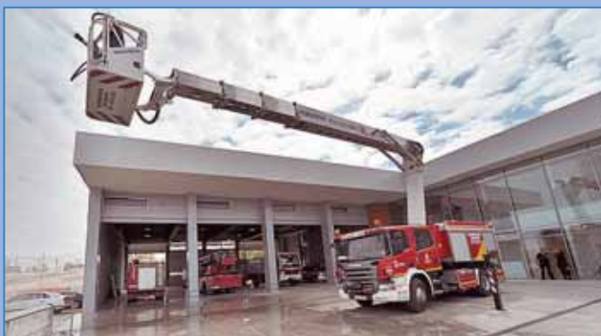
Los Bomberos se han trasladado al nuevo Parque, ubicado en Nueva Segovia y con unas instalaciones mucho más modernas y amplias que las de Padre Claret. / KAMARERO
