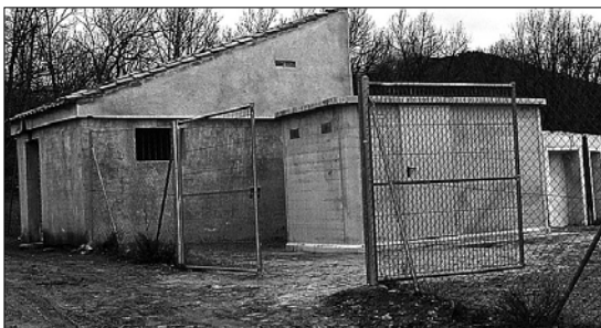
Nuevas instalaciones construidas en Collado para el suministro de agua. / G.H.
