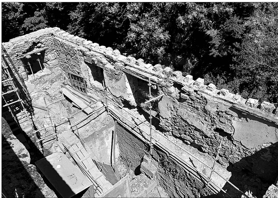
Estado actual de las obras que se ejecutan para la recuperación del Molino Cabila. / JUAN MARTÍN
