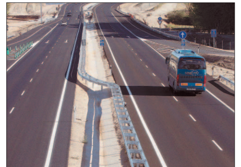
Las obras se han desarrollado en dos años. /B.V.
