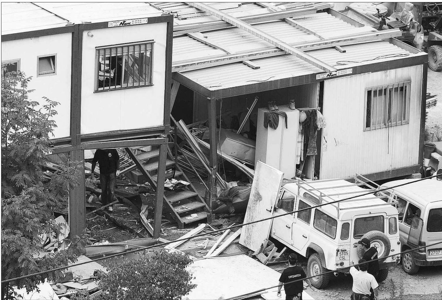
Agentes de la 'Ertzaintza' evalúan los daños ocasionados por la bomba de ETA, que afectó a las casetas de las empresas que realizan las obras de la A-8. / JUAN HERRERO (EFE)
