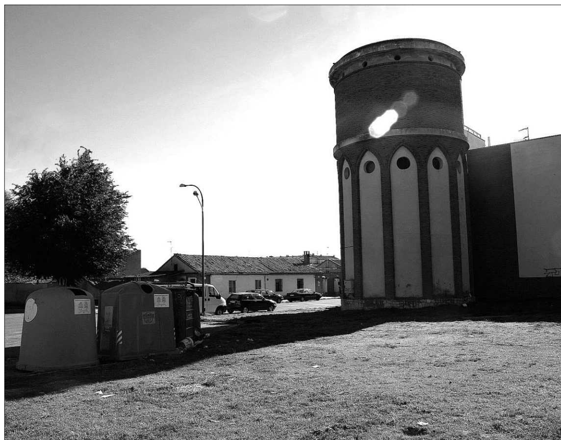
Terrenos en el plan parcial Canteras donde se construirán la guardería y el edificio administrativo./GABRIEL GÓMEZ
