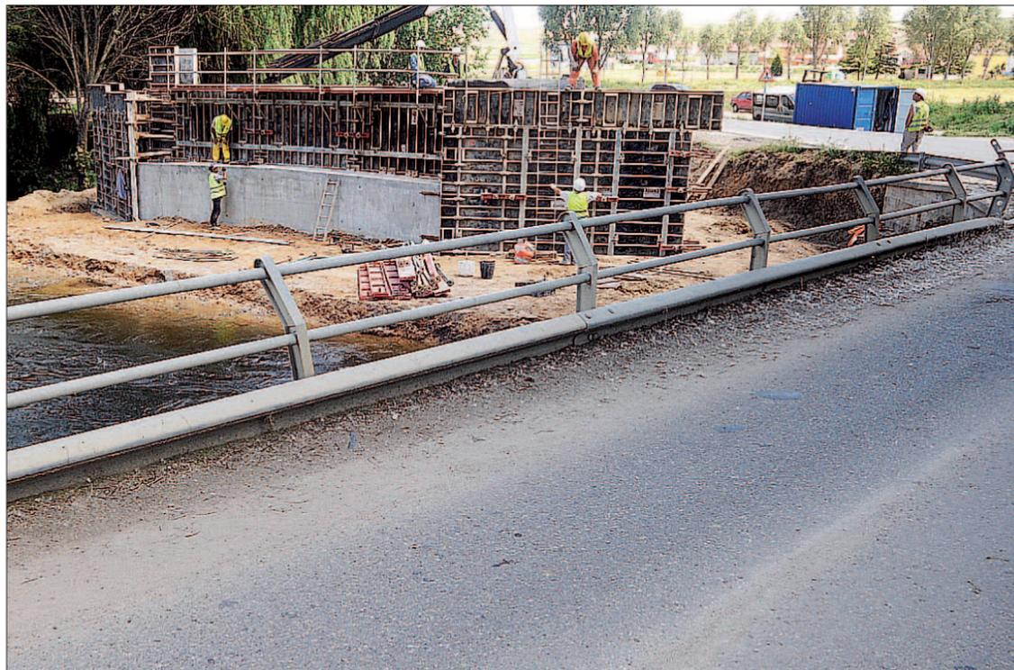
En los últimos días se han construido los encofrados para colocar las vigas que sirvan de plataforma al nuevo puente. / A. C.
