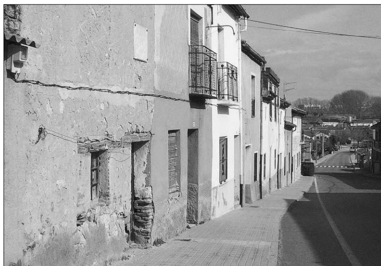
Todo apunta a que el consultorio se situará en el solar de este edificio. / A. PINELA
