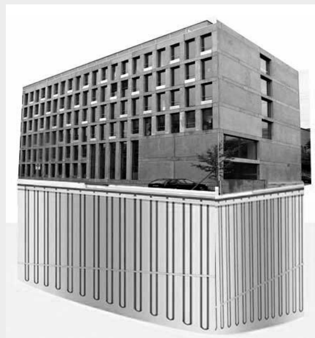
EDIFICIO CON CAPTADOR GEOTÉRMICO. / IMAGEN CEDIDA POR SOLVER
