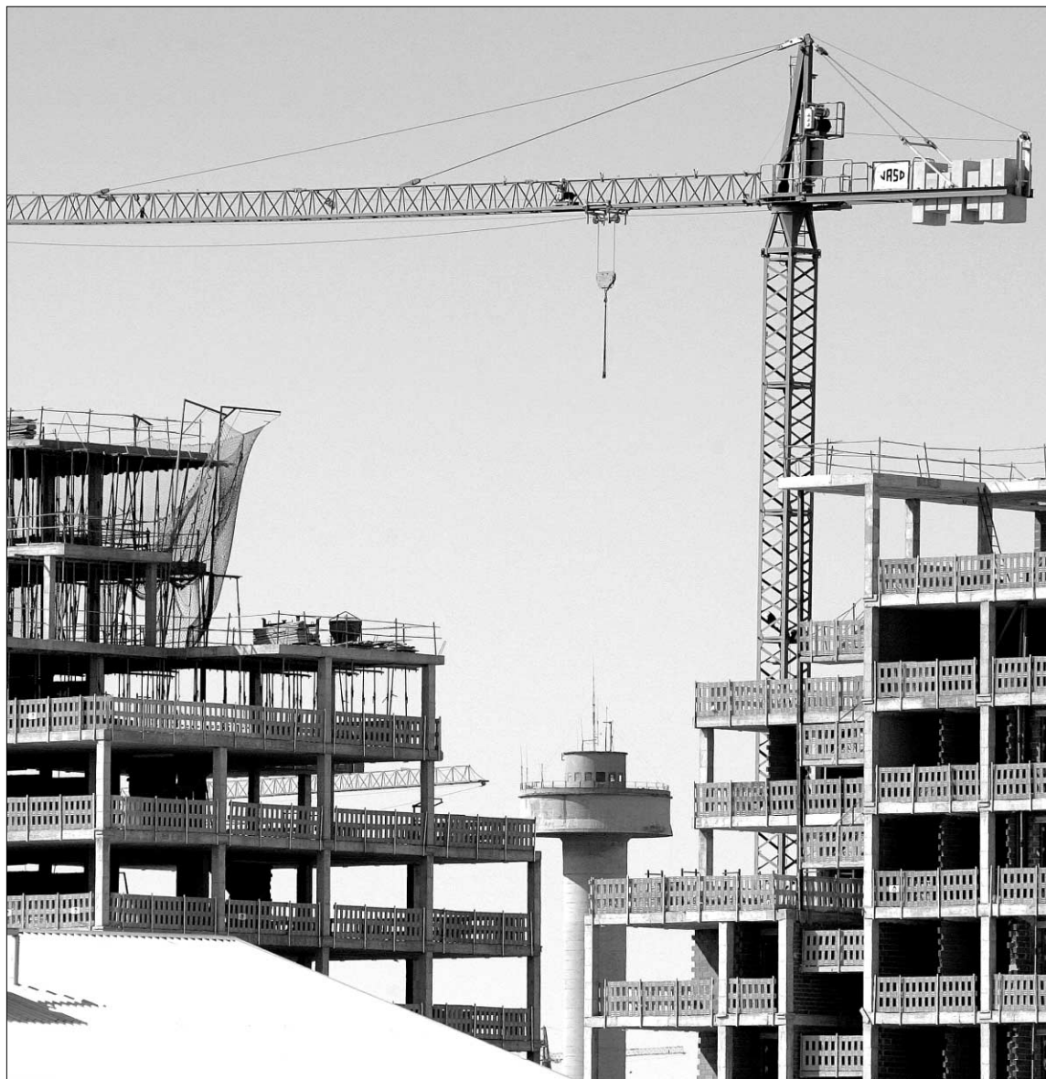
Construcción de dos bloques de edificios de viviendas. / CONSUELO LÓPEZ
