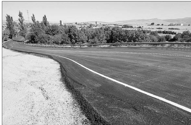
Vial provisional actual a la estación del AVE. /F. PEÑALOSA
