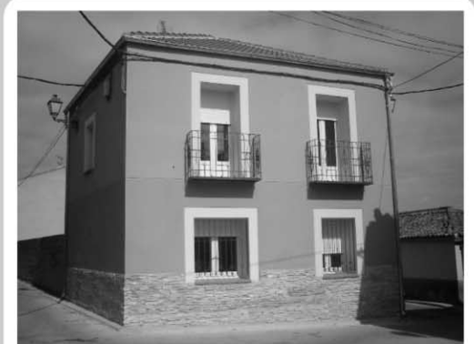
Detalle de la fachada
