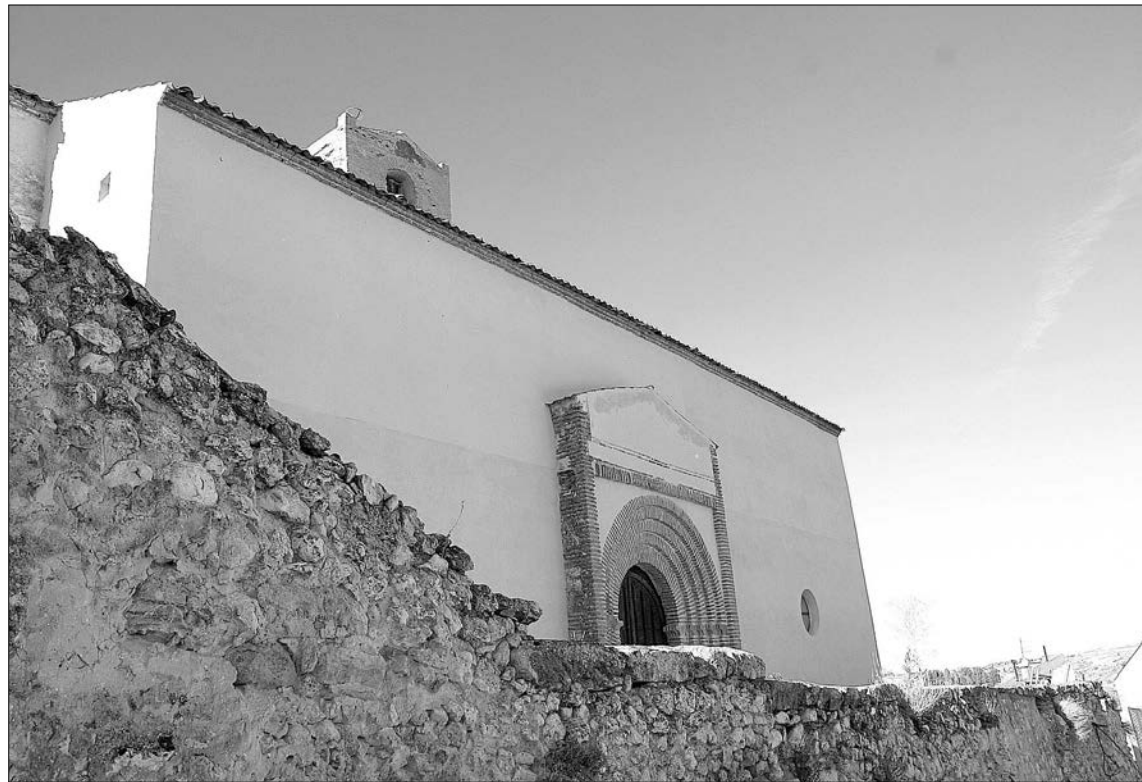
Así ha quedado la fachada principal de la iglesia tras los trabajos acometidos en ella./GABRIEL GÓMEZ
