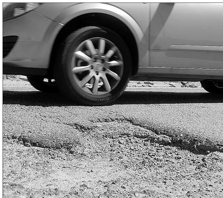
Los baches son un elemento más de casi todas las vías del área. /KAMARERO
