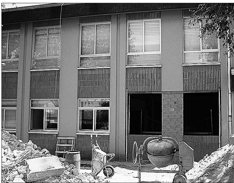
Comienzan las obras en el C.R.A Los Campos Castellanos. /LUCIO MARTIN
