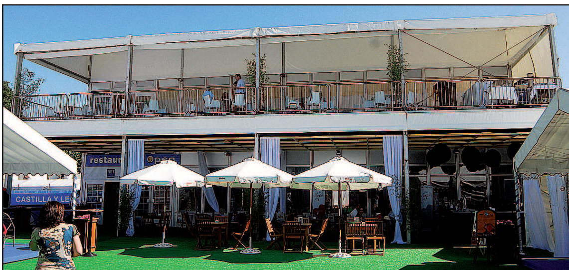
El restaurante de dos plantas tardó diez días en montarse por completo
