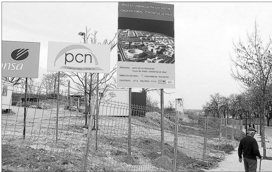
Las obras de urbanización del sector I-Plaza de Toros comenzaron a principios del pasado año/KAMARERO
