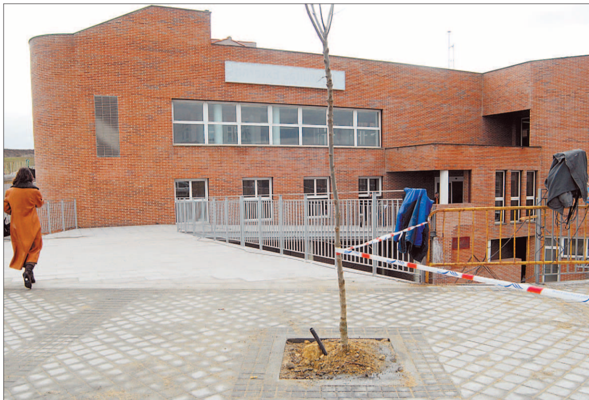
Zona de acceso peatonal al edificio de Consultas Externas del Hospital General./KAMARERO
