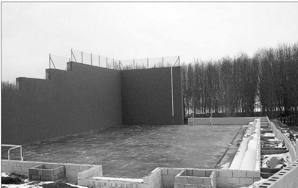
Los trabajos de reforma y acondicionamiento del frontón dejan la instalación preparada para hacer su posible cubierta. /A.P.
