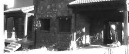
Estructura de madera de 1ª calidad (pino de Valsain) (Pilares forjados, vigas, porches,...)
