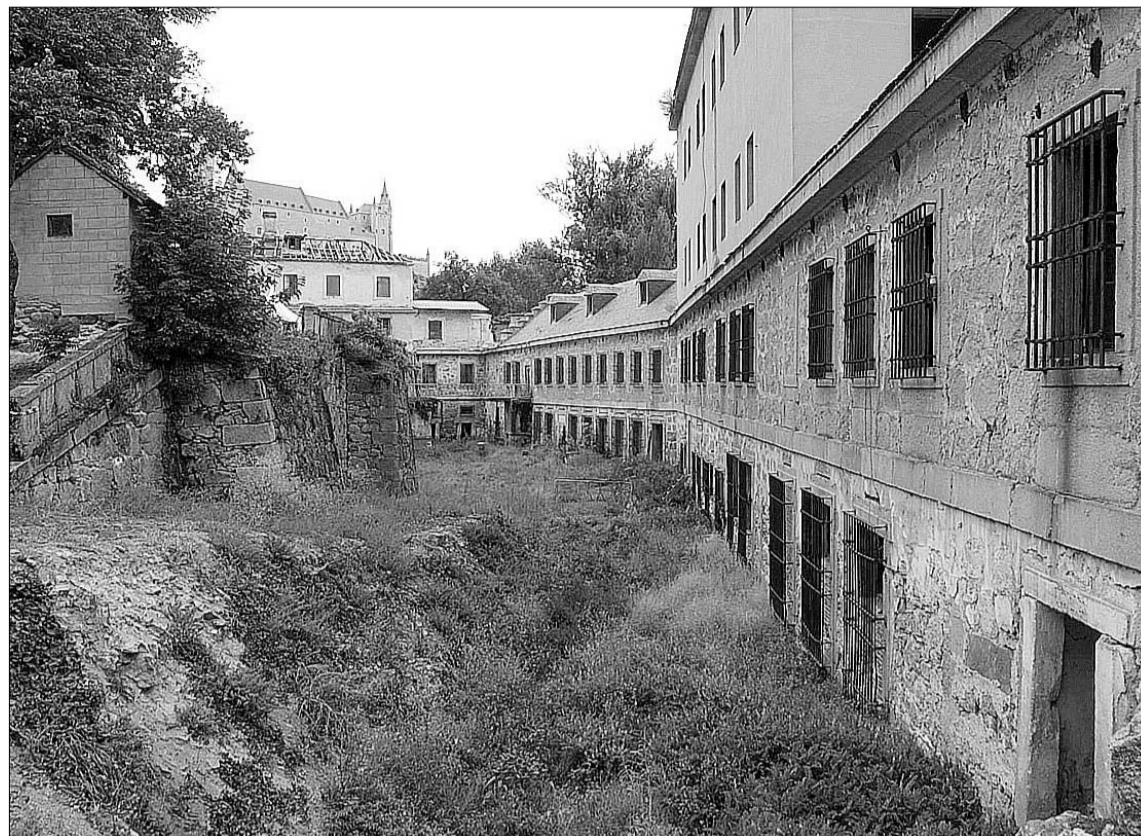
Imagen de archivo del patio bajo de la Casa de la Moneda, construida por encargo de Felipe II/FERNANDO PEÑALOSA
