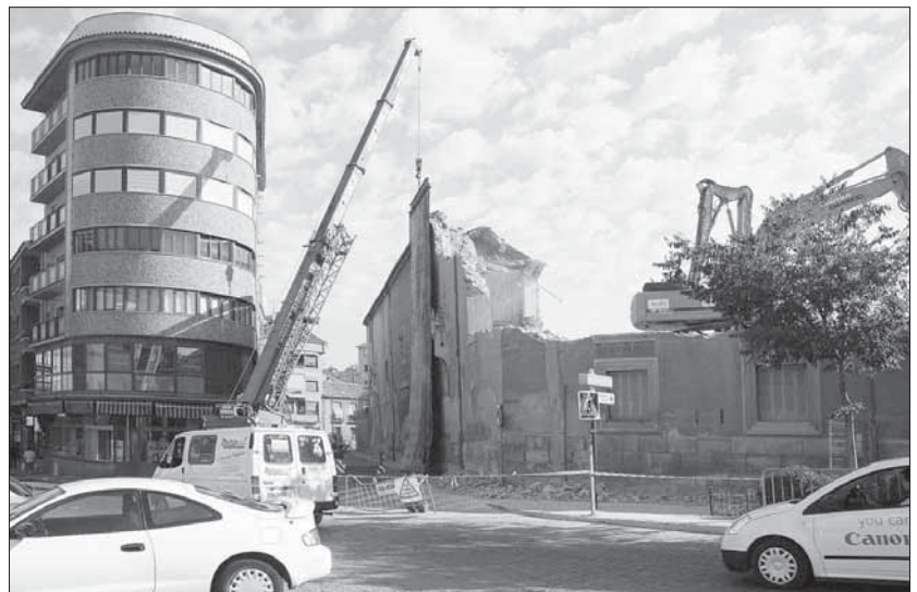
Los trabajos de demolición en el antiguo Regimiento están afectando puntualmente al tráfico en la zona. / F. PEÑALOSA
