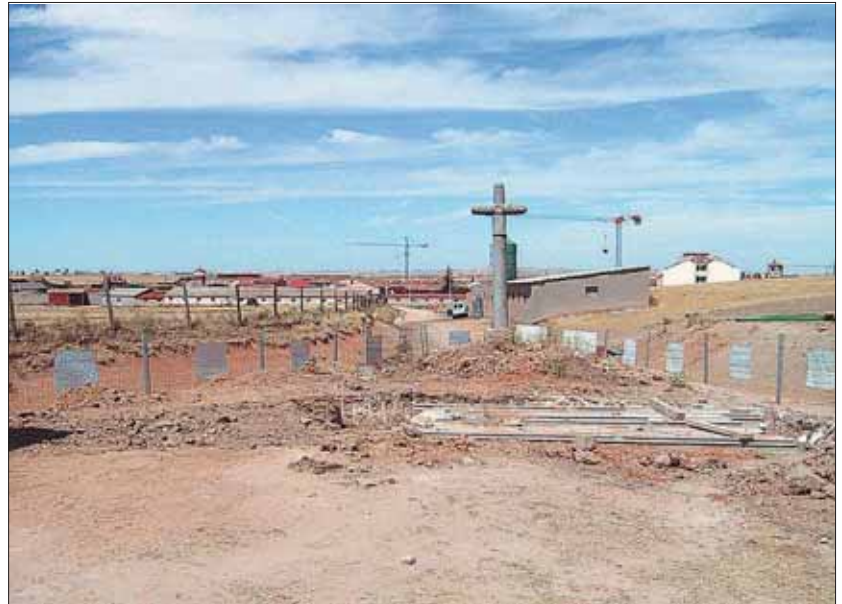
Las obras han comenzado con el movimiento de tierras y la explanación de la zona de El Oteruelo. / EL ADELANTADO
