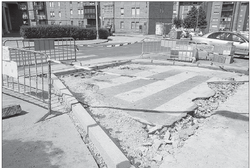
Imagen de las obras que se están ejecutando en uno de los pasos de cebrá de Marqués de Lozoya. / FERNANDO PEÑALOSA
