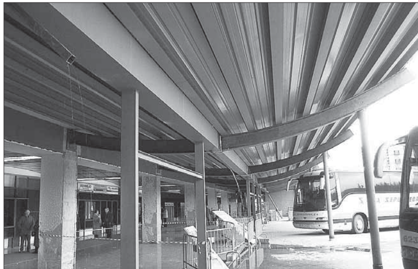
Los trabajos se centran en la construcción de la marquesina y el cerramiento con cristalerías y puertas automáticas/KAMARERO
