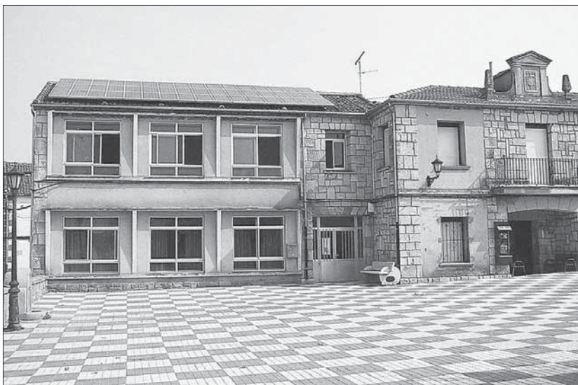
Imagen del Ayuntamiento, sobre cuyo tejado se encuentran los paneles solares que posibilitan la producción energética. / F.D.
