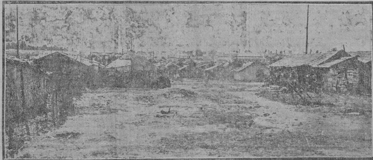
Los solares que van quedando con motivo del constante derribo
