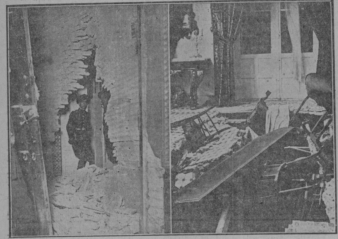
Dos fotos de los efectos de la explosión.—Una vista de cómo quedó el salón de recibir después de estallar una bomba, y enorme boquete abierto por ésta en uno de los muros del piso bajo.
