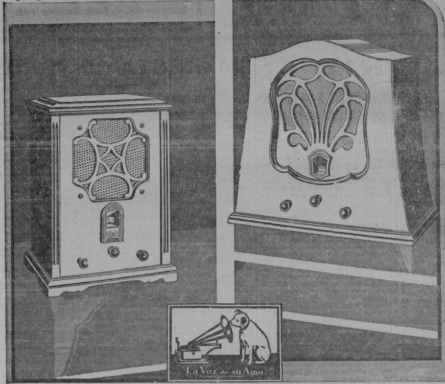
Nuevo receptor Superheterodino de 7 válvulas con altavoz de gran tamaño. Placa terminal para conexiones de pick-up y altavoz extra. Precio (corriente alterna) 1.075 Ptas.
