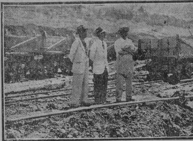
El ingeniero de la Junta de Obras del Puerto señor Buiza y el representante de la entidad constructora, señor Manteón, explicando á nuestro redactor el alcance del proyecto y la marcha de los trabajos.
