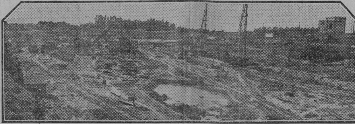
Una vista general del estado de las obras de construcción de la esclusa en la desembocadura del canal de la Corta de Tablada.
