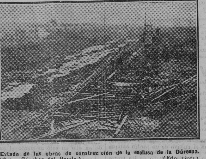
Estado de las obras de construcción de la esclusa de la Dársena. (Fotos Sánchez del Pando.)
