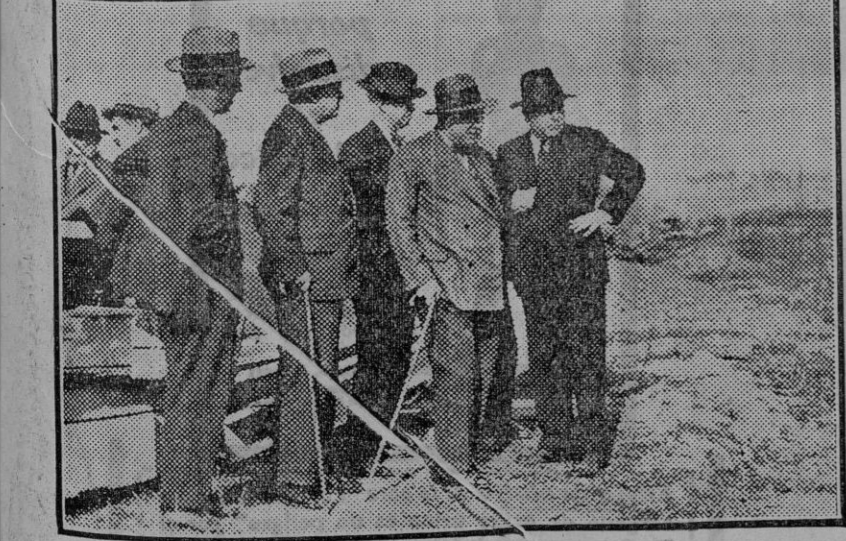
DE LA VISITA DEL DIRECTOR GENERAL DE OBRAS PUBLICAS El señor Salmerón viendo las obras de la Dársena. (Fdo. Gori.)
