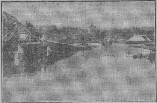
Puente de la carretera de Arcos a Cortes de la Frontera, derrumbado por la corriente.
