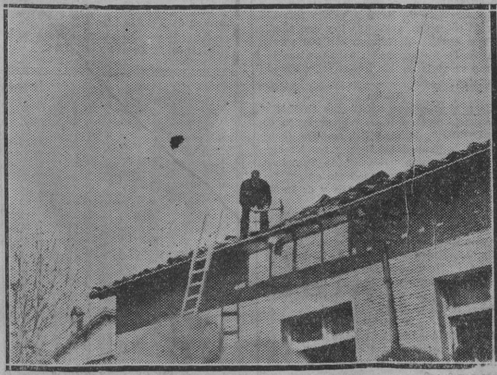
ESTELLA. Momento en el cual el concejal nacionalista don Jesús de Ugarte inicia las obras de derribo del Centro de Obreros para la apertura de la Calle de la Estación y el Ensanche
