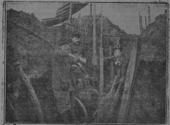
MEUSE.—Bomba aspirante, manibrada por suavos y destinada a sacar las trincheras y a quitar el barro. Al fondo un perro sanitario alemán escapado de las líneas.
