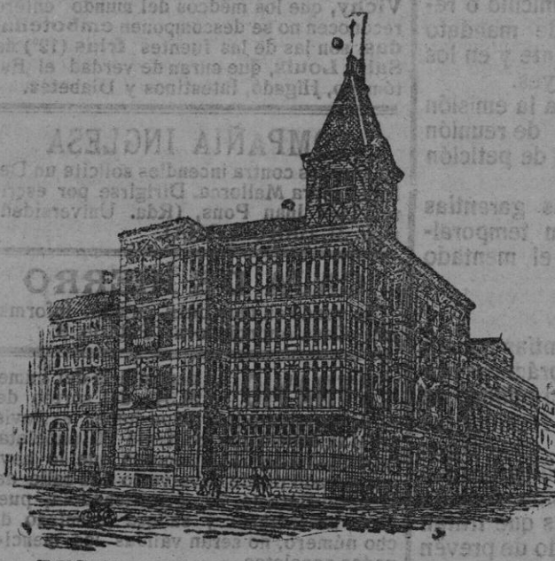
Edificio propio de la Sociedad en Pamplona
