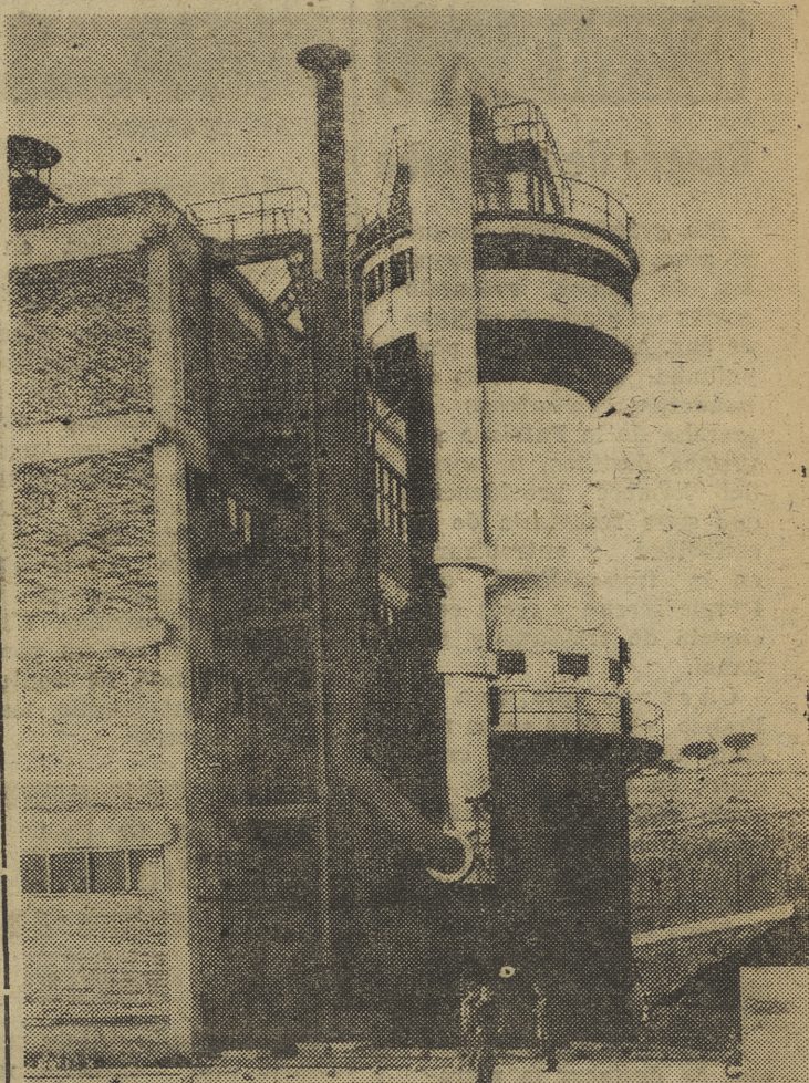
Vista de una de las grandes torres atomizadoras de la nueva fábrica de Henkel Ibérica en Montornés del Vallés. Las tres figuras humanas próximas a la base de la torre permiten hacerse una idea de las proporciones de la misma
