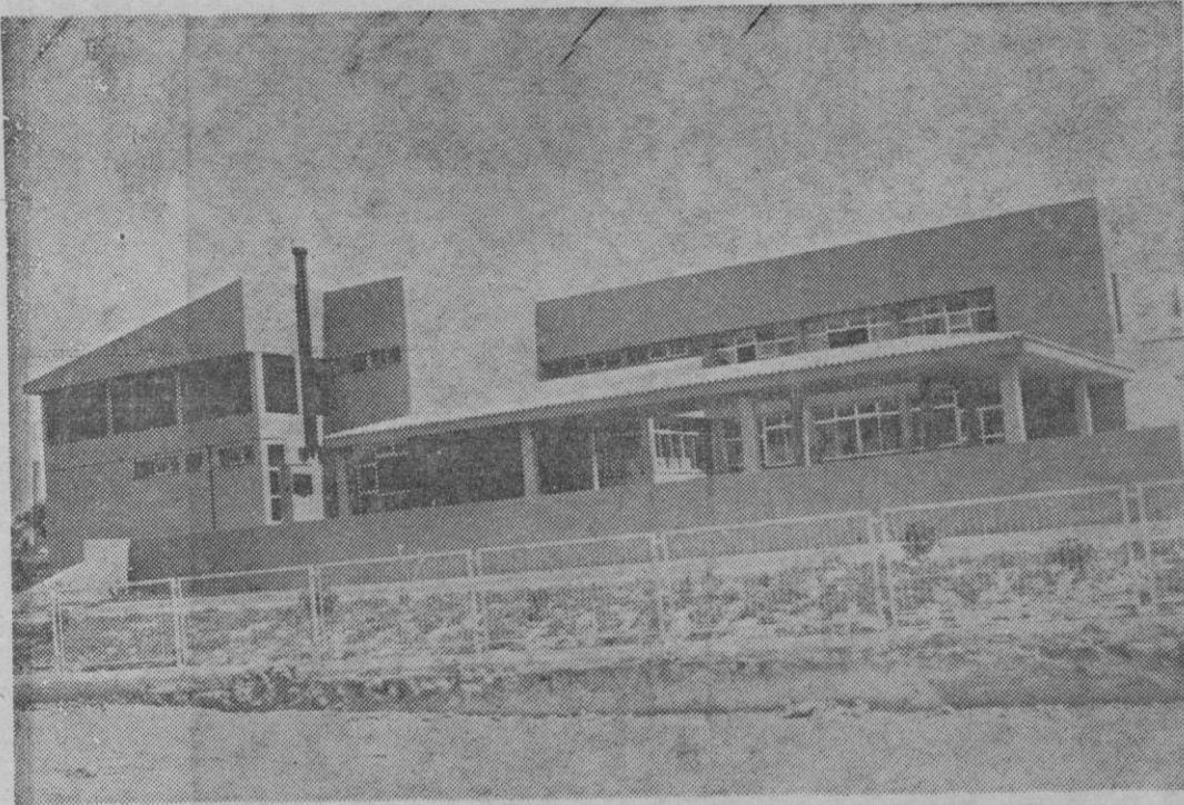
Las obras del Colegio de Santa Margarita, han finalizado y el próximo, ya cercano, curso escolar, será el primero de la ya naciente historia del centro. -- (Foto Matías Pascual).
