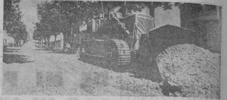
Las obras en marcha del Paseo Jaime III, que costea don Juan de Vidal y Salvá. -- (Foto Clar - Lluchmajor).
