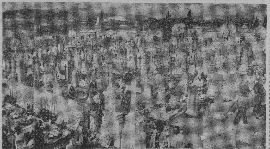
Palma puede contar dentro de dos años con todas las plazas de enterramiento necesarias para una ciudad que ha crecido quizás en demasía. El Cementerio de Palma había quedado pequeño; de ahí la importante obra de ampliación.
