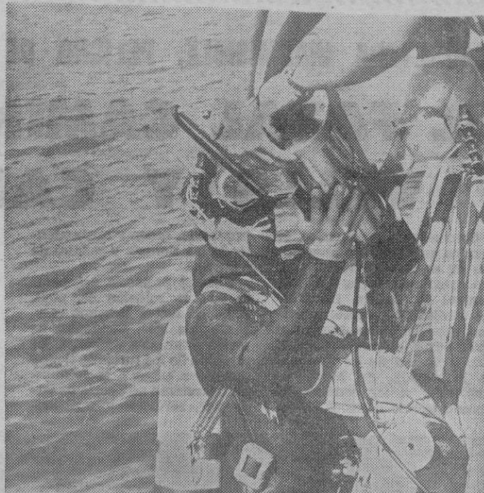
Un buzo se introduce en el mar con la cámara que serviría para ver por el televisor el estado de los emisarios.
