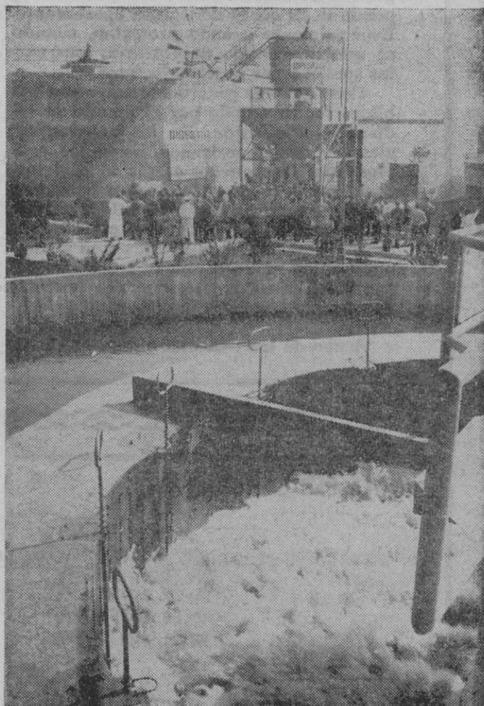
ESTE CHORRO DE AGUA ESTA PRODUCIDO POR UNA TURBINA DE UNO DE LOS AEROACCELERADORES, FORMANDO PARTE DE LOS DISTINTOS TANQUES Y COMPLICADOS MECANISMOS, QUE CONVIERTEN LAS AGUAS RESIDUALES EN AGUA CLARA REUTILIZABLE PARA RIEGOS.
