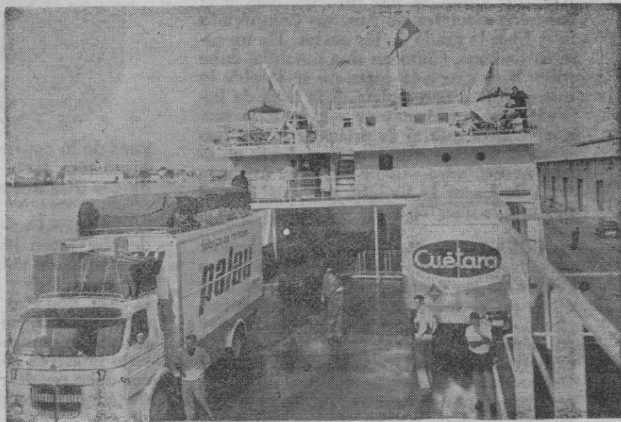
Camiones sobre la cubierta garaje.
